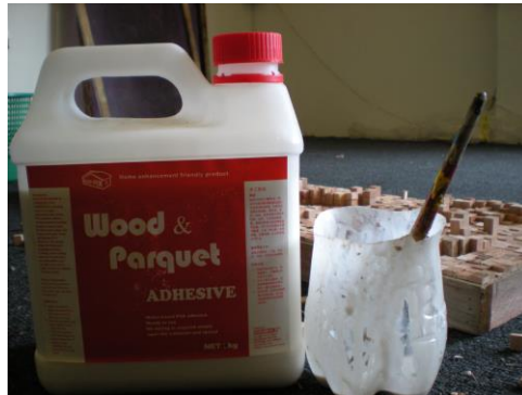
Gambar 6. Gam kayu digunakan untuk menampal cebisan kayu.
